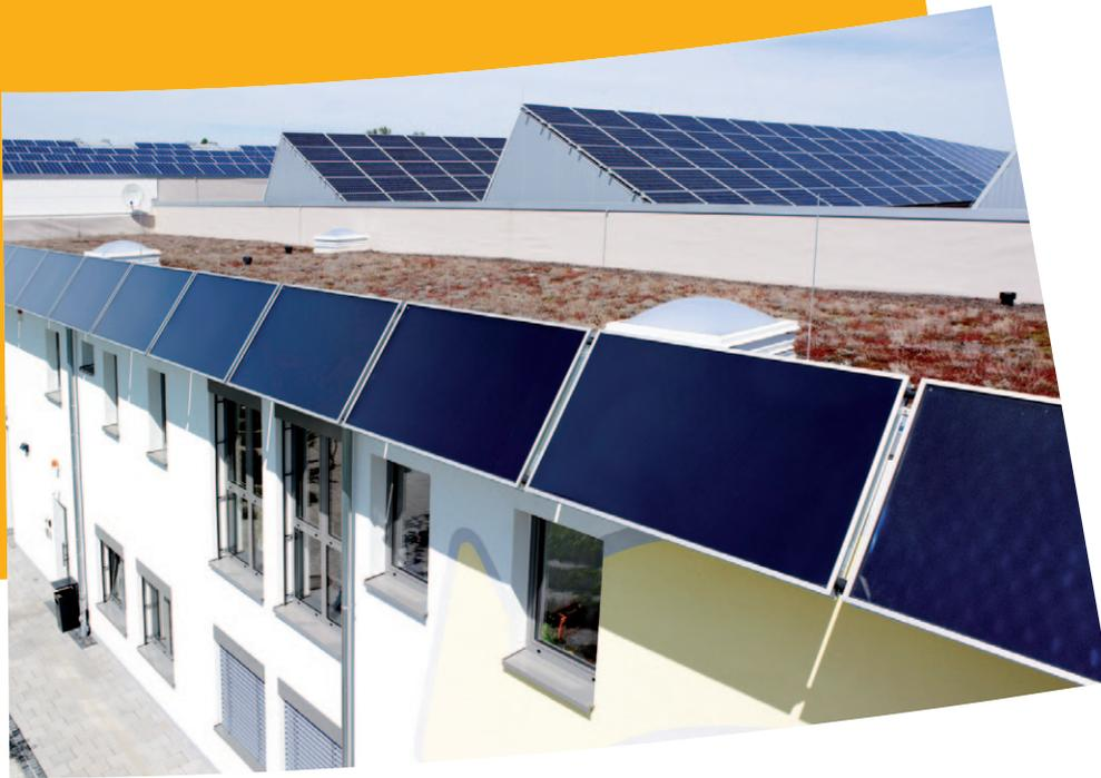
Der **EURO L20 MQ AR** ist ein leistungsstarker Flachkollektor im Querformat. Als Kollektorband verschaltet liefert er hohe Erträge im Warmwasser- und im Raumwärmebereich.
