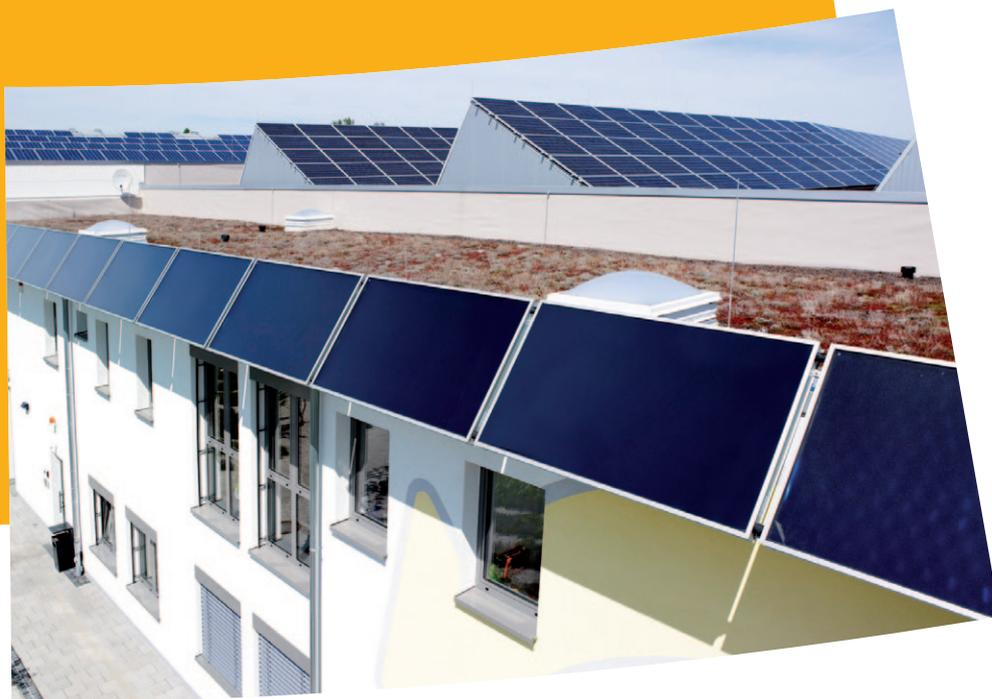
L'EURO L20/L40 MQ est un capteur solaire plan très performant pour le montage horizontal. Il peut être installé en bandeaux. Il garantit un gain élevé pour la préparation de l'eau chaude et l'aide au chauffage.
