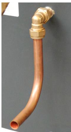
Stützhülsen in die 15mm Anschlüsse am Speicher sowie in die oberen Öffnungen der Anschlussrohre stecken und dann die 90° Klemmringverschraubungen mit den Anschlussbögen montieren
